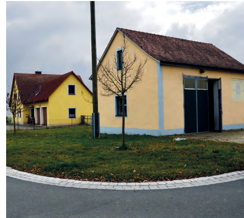
Feuerwehrgerätehaus Heglau Foto: Tamara Dürnberger
