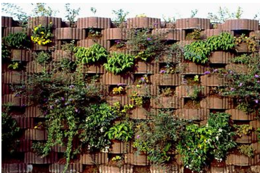
Abb. 1: Unterschiedliche Kompostsubstrate zur Begrünung einer Lärmschutzsteilwand
